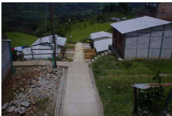
Figura 10: Ejemplos de Cubierta en Eternit color gris
