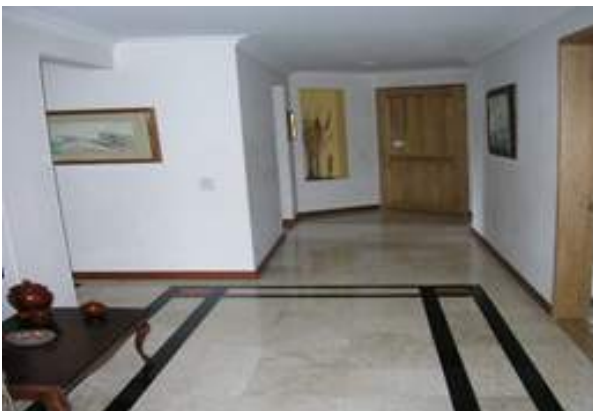
Figura 37: Ejemplos de Pisos en Mármol
