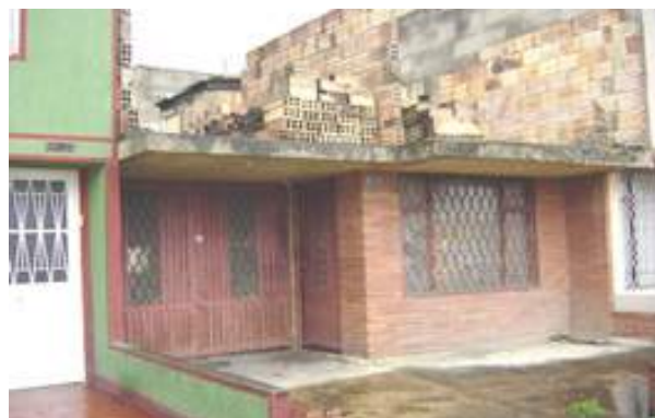
Figura 9: Ejemplos de Entrepiso (Cubierta provisional o prefabricada)
