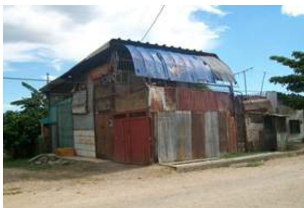
Figura 17: Ejemplos de Muros en Materiales de desecho o Esterilla.
