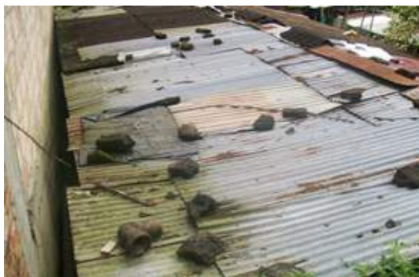
Figura 7: Otros ejemplos de Cubierta en Materiales de desecho
