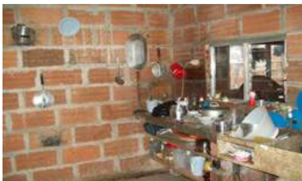
Figura 26: Ejemplos de Muros sin cubrimiento
