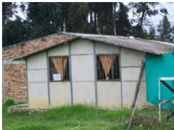
Figura 20: Ejemplos de Muros prefabricados
