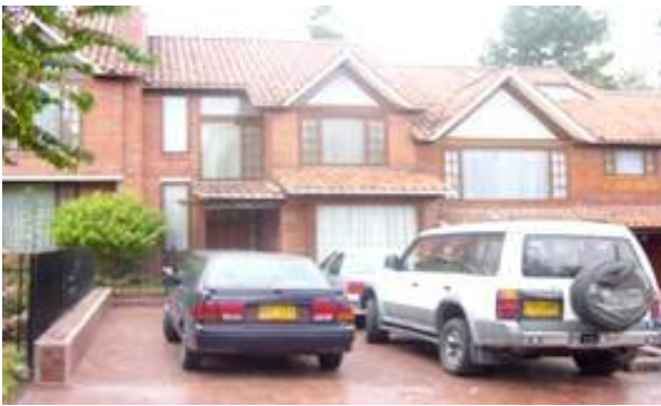
Figura 14: Ejemplos de Cubierta con Placa sencilla y teja de barro
