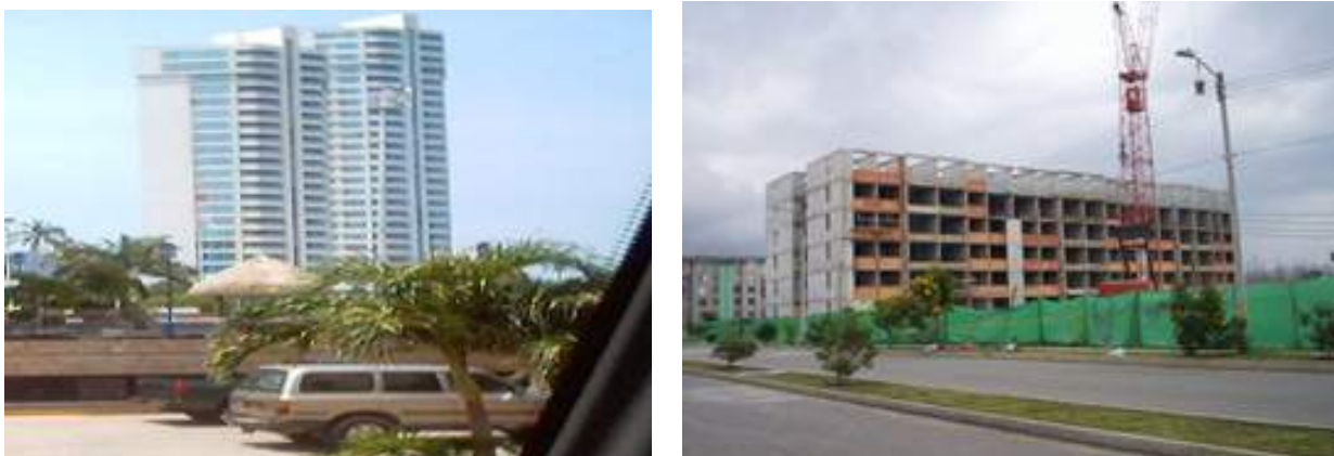
Figura 5: Ejemplos de Armazón en Concreto de cuatro o más pisos
