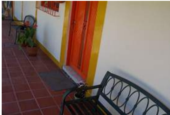
Figura 33: Ejemplos de Pisos en Baldosa común de cemento
