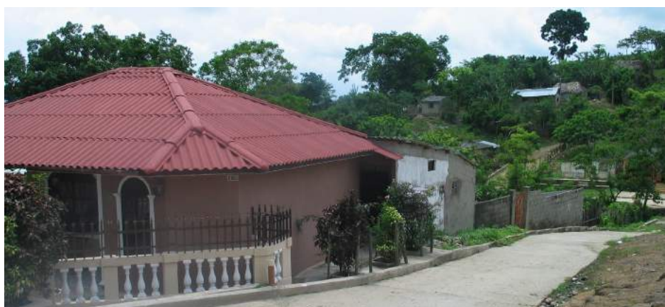
Figura 11: Ejemplo de Cubierta en Eternit de color ladrillo
