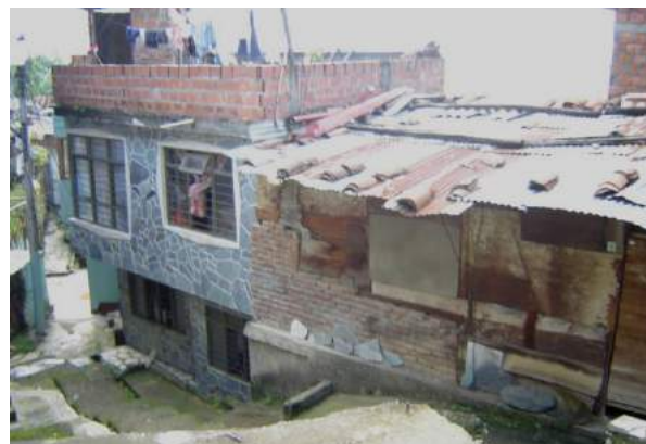
Figura 7: Otros ejemplos de Cubierta en Materiales de desecho
