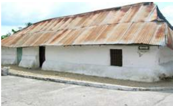
Figura 18: Ejemplos de Muros en Bahareque, adobe o tapia
