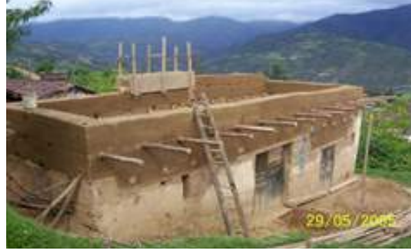
Figura 1: Ejemplos de Armazones en madera y tapia
