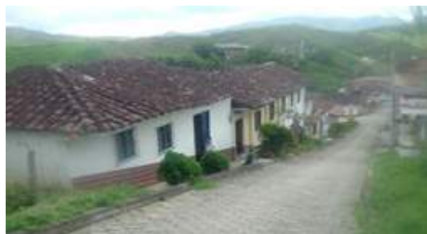
Figura 12: Ejemplos de Cubierta en Teja de Barro
