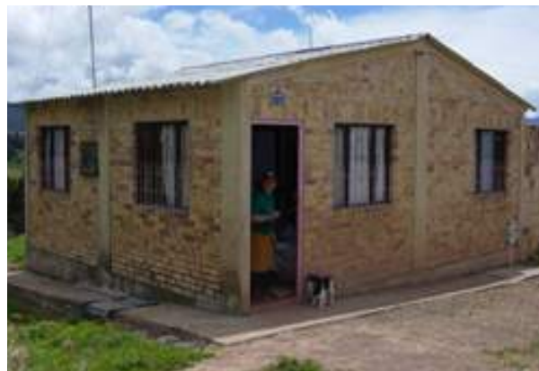
Figura 8: Ejemplos de Cubierta en Zinc y Eternit Rústico
