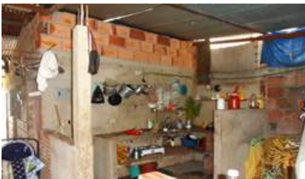
Figura 71: Ejemplos de cocinas con cubrimiento en Pañete
