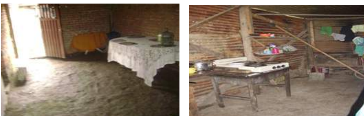
Figura 31: Ejemplos de Pisos en Tierra pisada
