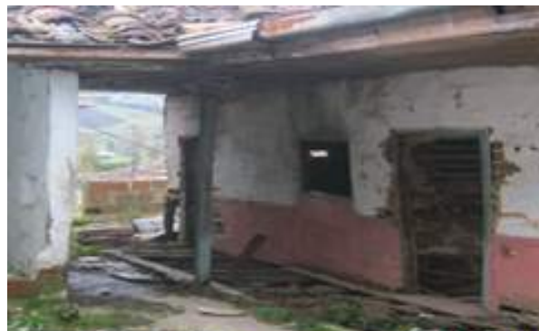
Figura 18: Ejemplos de Muros en Bahareque, adobe o tapia
