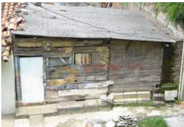
Figura 8: Ejemplos de Cubierta en Zinc y Eternit Rústico
