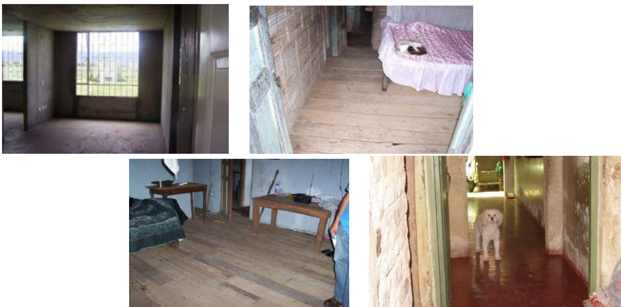
Figura 32: Ejemplos de Pisos en Cemento y Madera burda
