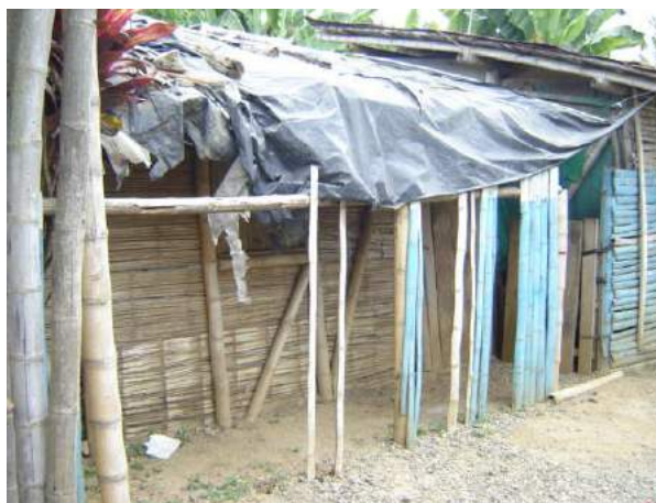
Figura 6: Ejemplos de Cubierta en Materiales de desecho
