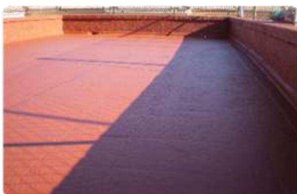
Figura 15: Ejemplos de Cubierta con Placa impermeabilizada
