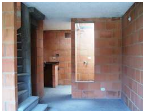
Figura 21: Ejemplos de Muros en Ladrillo o Bloque
