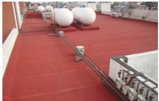
Figura 15: Ejemplos de Cubierta con Placa impermeabilizada
