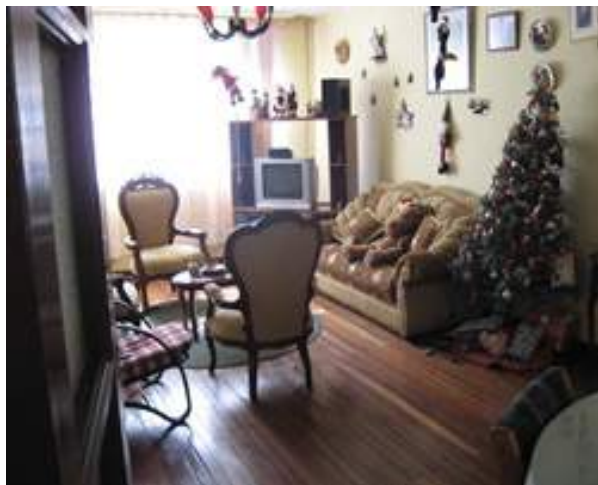
Figura 34: Ejemplos de Pisos en Listón machihembrado
