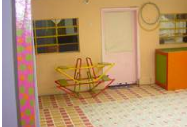
Figura 33: Ejemplos de Pisos en Baldosa común de cemento
