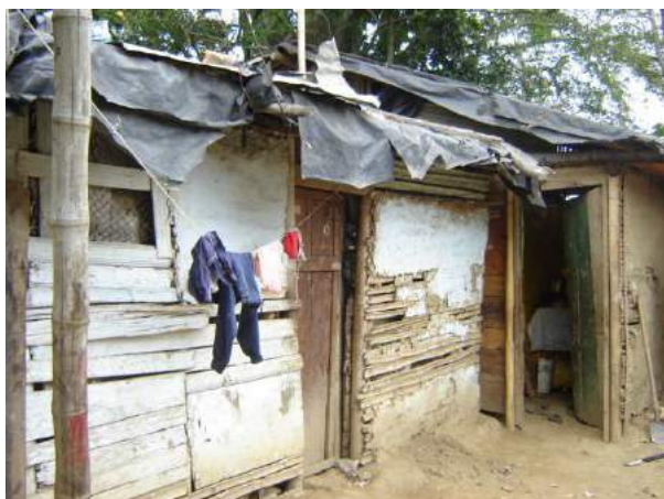
Figura 6: Ejemplos de Cubierta en Materiales de desecho
