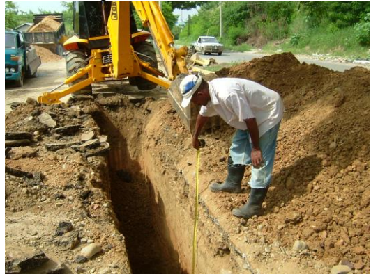
Imagen 12. Ancho de excavaciones
