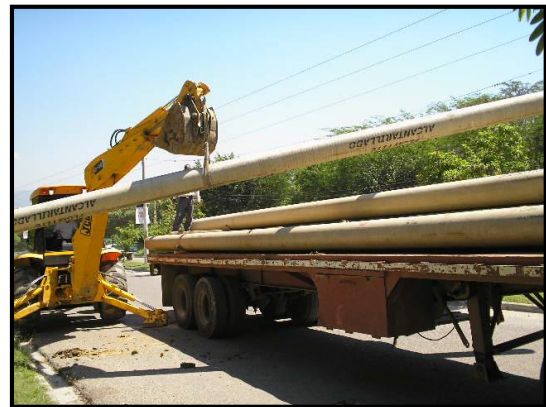
Imagen 13. Suministro y transporte de tubería
